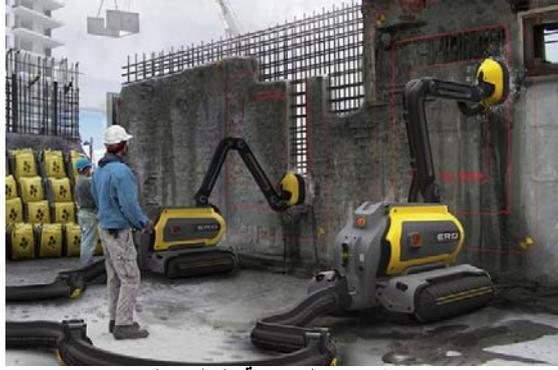
الشكل (102-) روبوتات لإعادة تدوير الخرسانة بشكل مباشر (Robotics, 2014).
